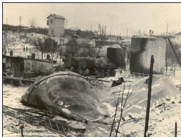
Рис. 1.7. Вид резервуара после разрушения и пожара
