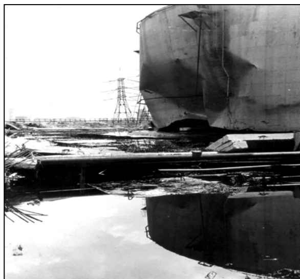
Рис. 1.13. Общий вид поврежденного РВС № 3
