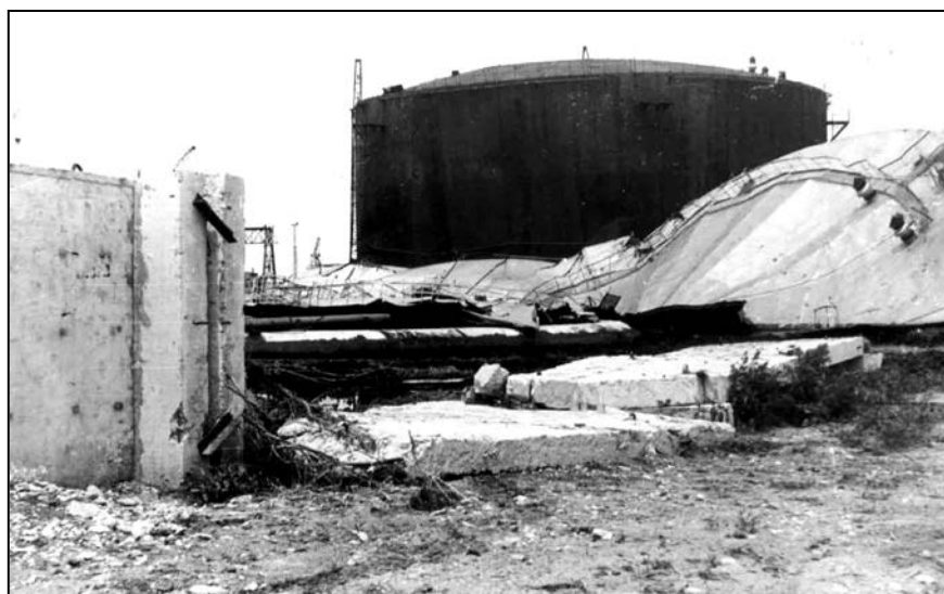
Рис. 1.14. Общий вид разрушенного железобетонного ограждения
