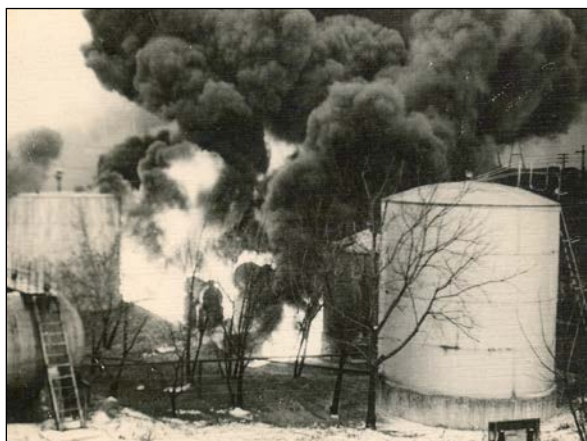
Рис. 1.6. Пожар на нефтебазе при разрушении РВС-700 м 3
