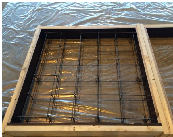
Рисунок 3.10 – Форма для заливки плит с металлической сеткой для армирования бетона
