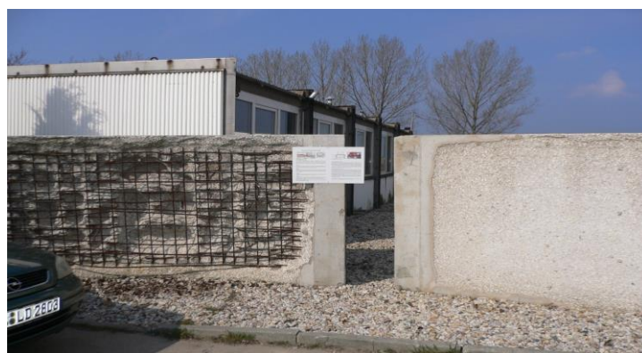
Рисунок 1.25 – Испытания железобетонных тубингов с добавкой и без добавки полипропиленовой фибры на огнестойкость
