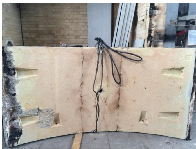
Рисунок 4.24 – Железобетонный тубинг после испытаний. Поперечные, нитевидные трещинообразования с обогреваемой стороны
