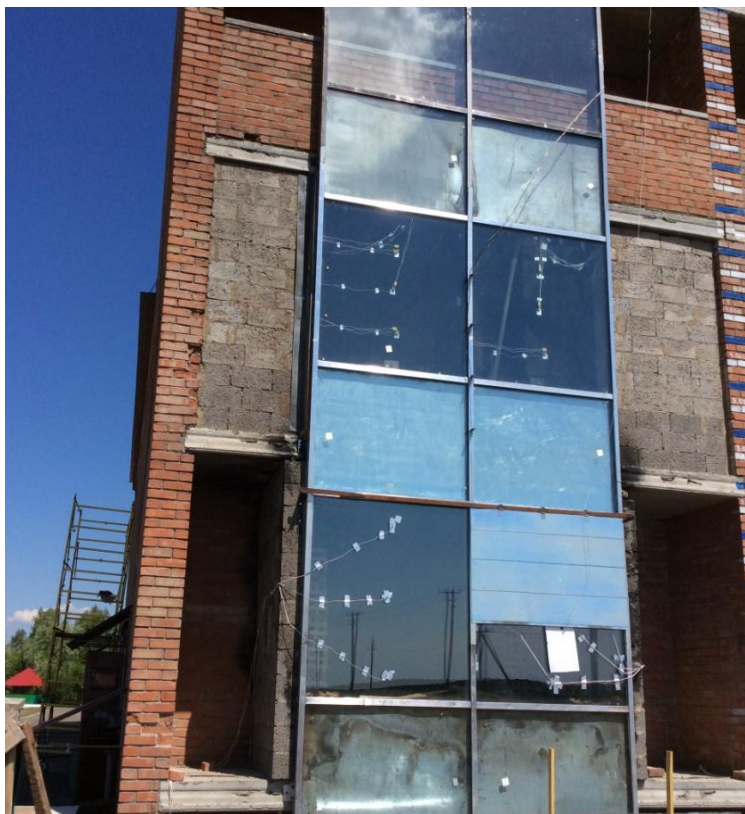
Рисунок 4.3 – Общий вид светопрозрачного фасада с защитным экраном
