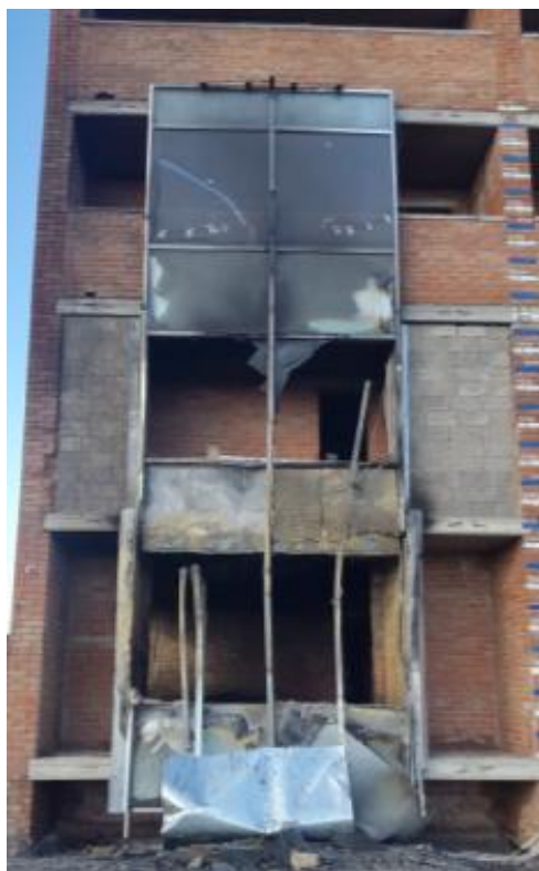
Рисунок 3.19 – Общий вид светопрозрачного фасада после испытаний
