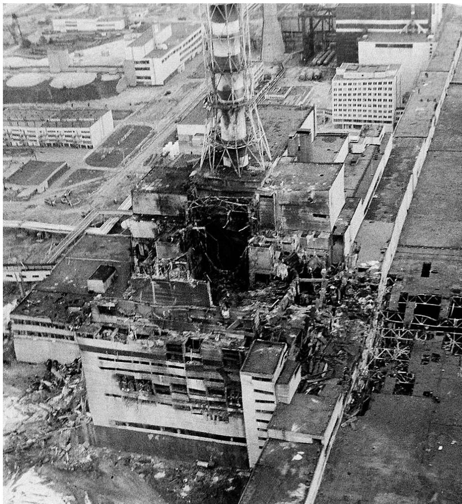
Рисунок 1.8 – Последствия взрыва и пожара на ЧАЭС
