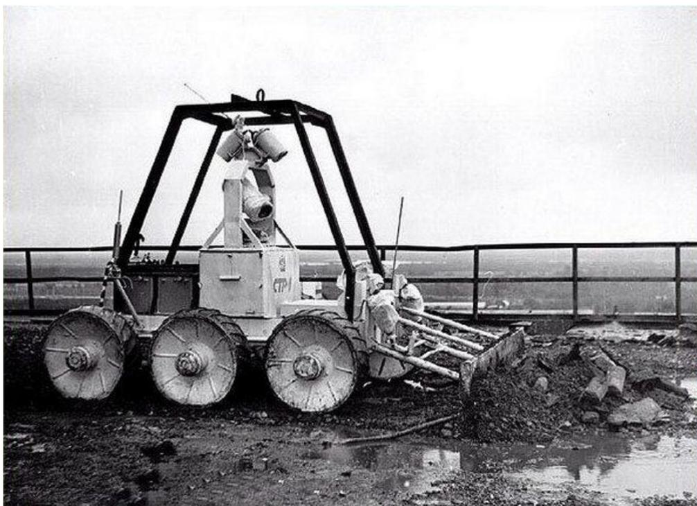
Рисунок 1.13 – Специализированный транспортный робот СТР-1 проводит работы по очистке кровли от радиоактивных обломков
