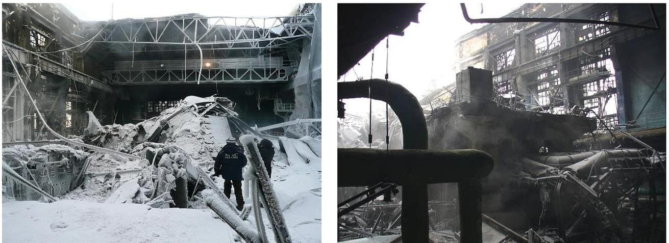
Рисунок 1.5 – Пожар в машинном зале ТЭЦ-1, г. Улан-Удэ
