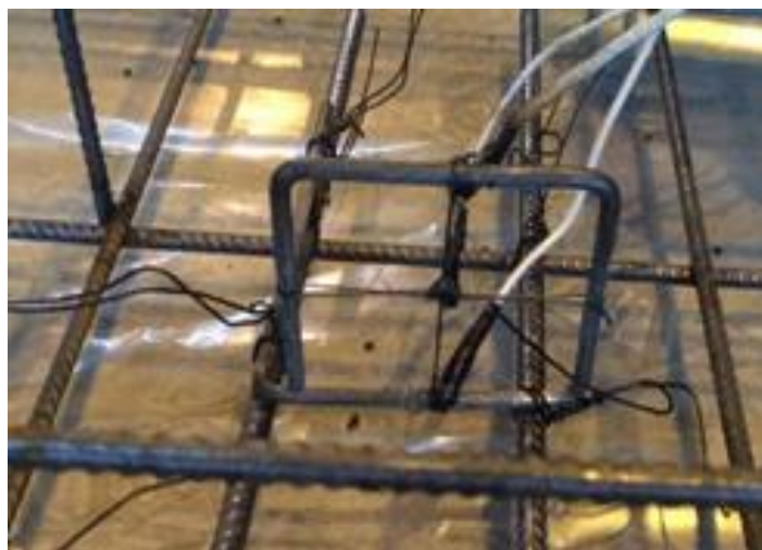
Рисунок 4 – Держатель с установленными термопреобразователями
