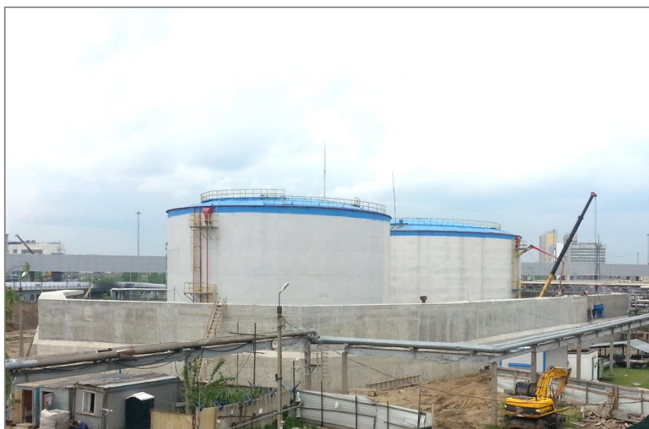
Рис. 4. Общий вид ограждения со стороны РВС № 3
