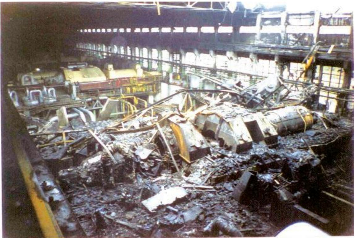
Рисунок 1.13 – Последствия пожара на Каширской ГРЭС-4 [10]
