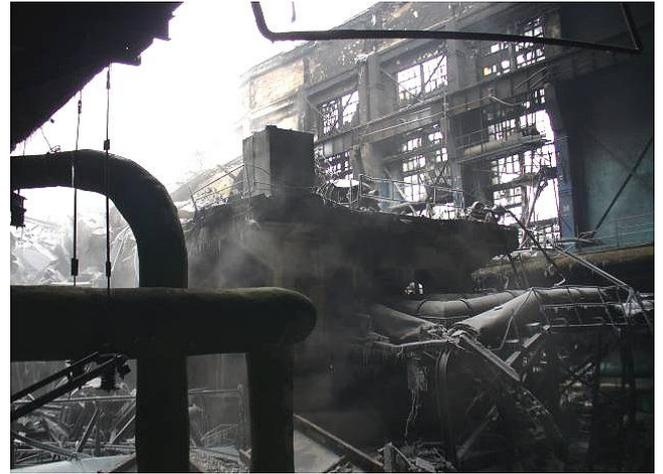
Рисунок 1.16 – Последствия пожара в машинном зале ТЭЦ-1, г. Улан-Удэ [10]:
