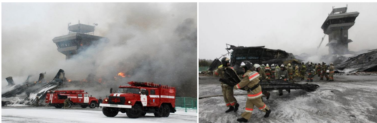
Рисунок 1.3 – Пожар в аэропорту «Черемшанка» под г. Красноярском
