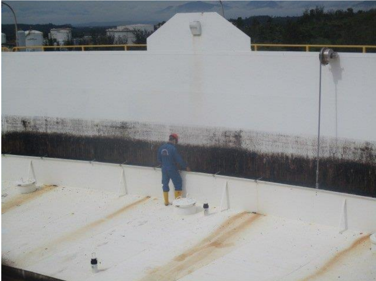
Рисунок 3.6 – Замер концентраций ПВС оператором в процессе откачки
