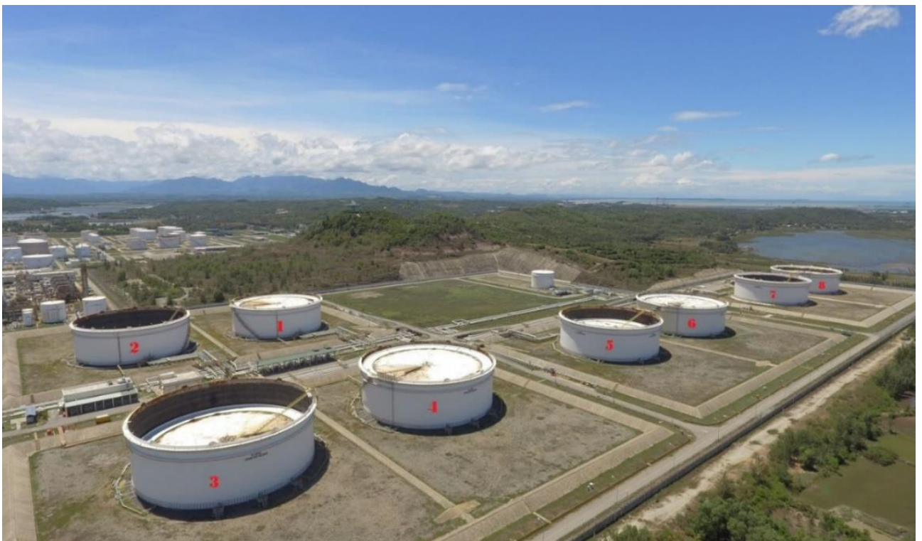
Рисунок 2.2 – РВСПК-65000 м 3 для хранения сырой нефти на НПЗ «Зунг Куат»
