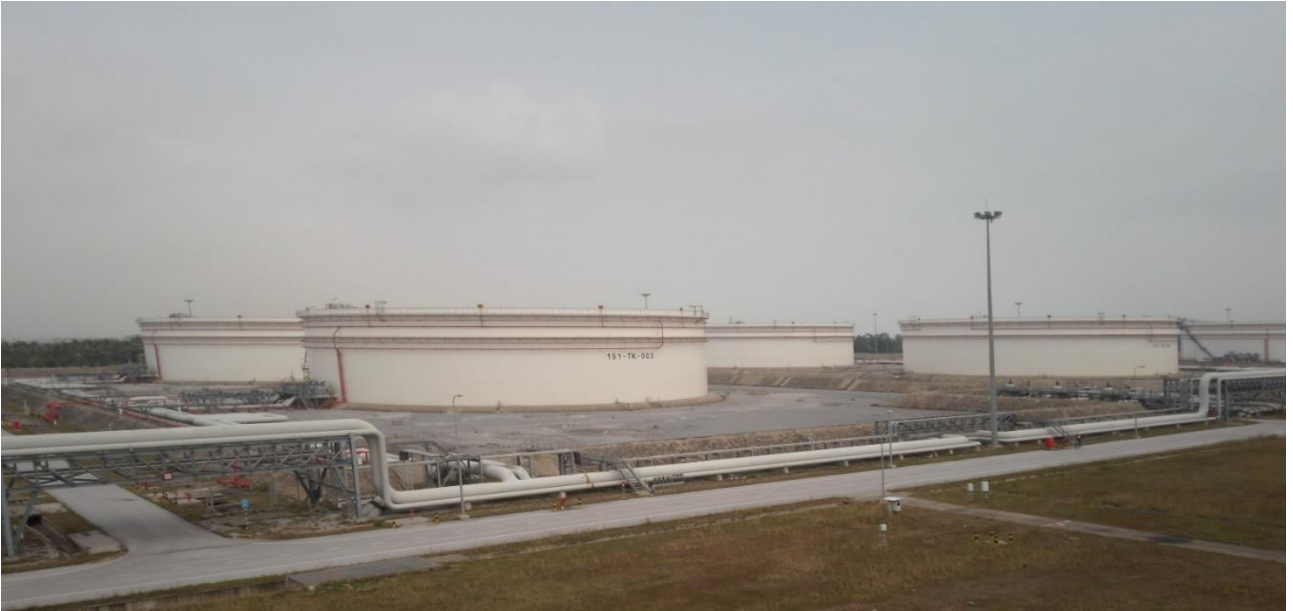
Рисунок 2.5 – Резервуары типа РВСПК-120000 м 3 на нефтебазе «Нги Сон»
