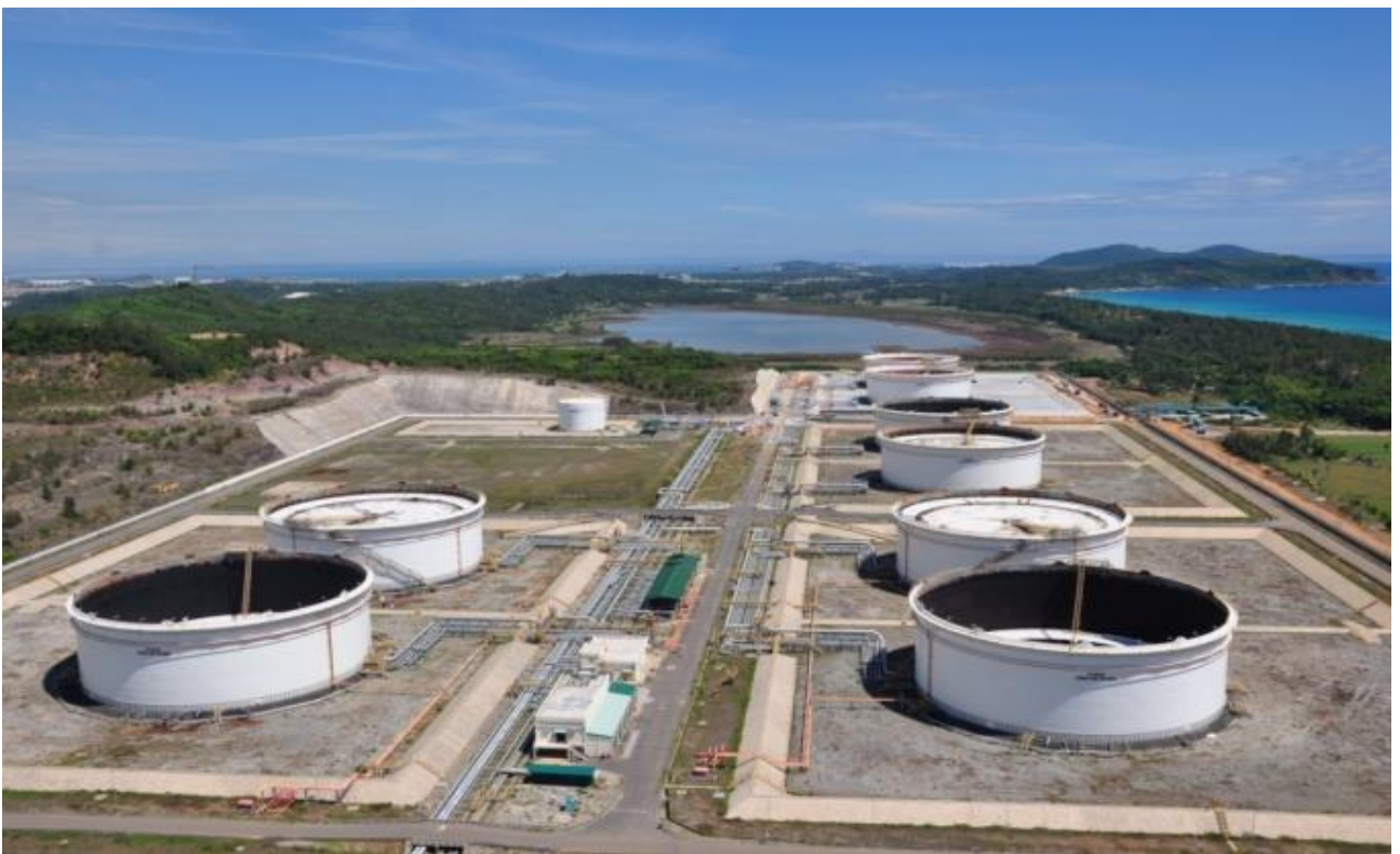
Рисунок 3.2 – Общий вид резервуарного парка НПЗ «Зунг Куат»
