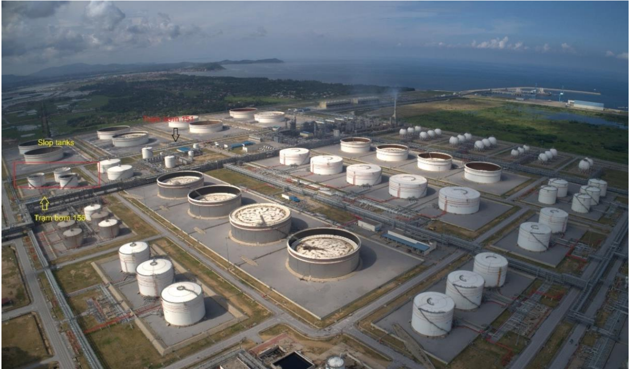
Рисунок 2.1 – Резервуарный парк НПЗ «Нги Сон» в провинции Тхань Хоа
