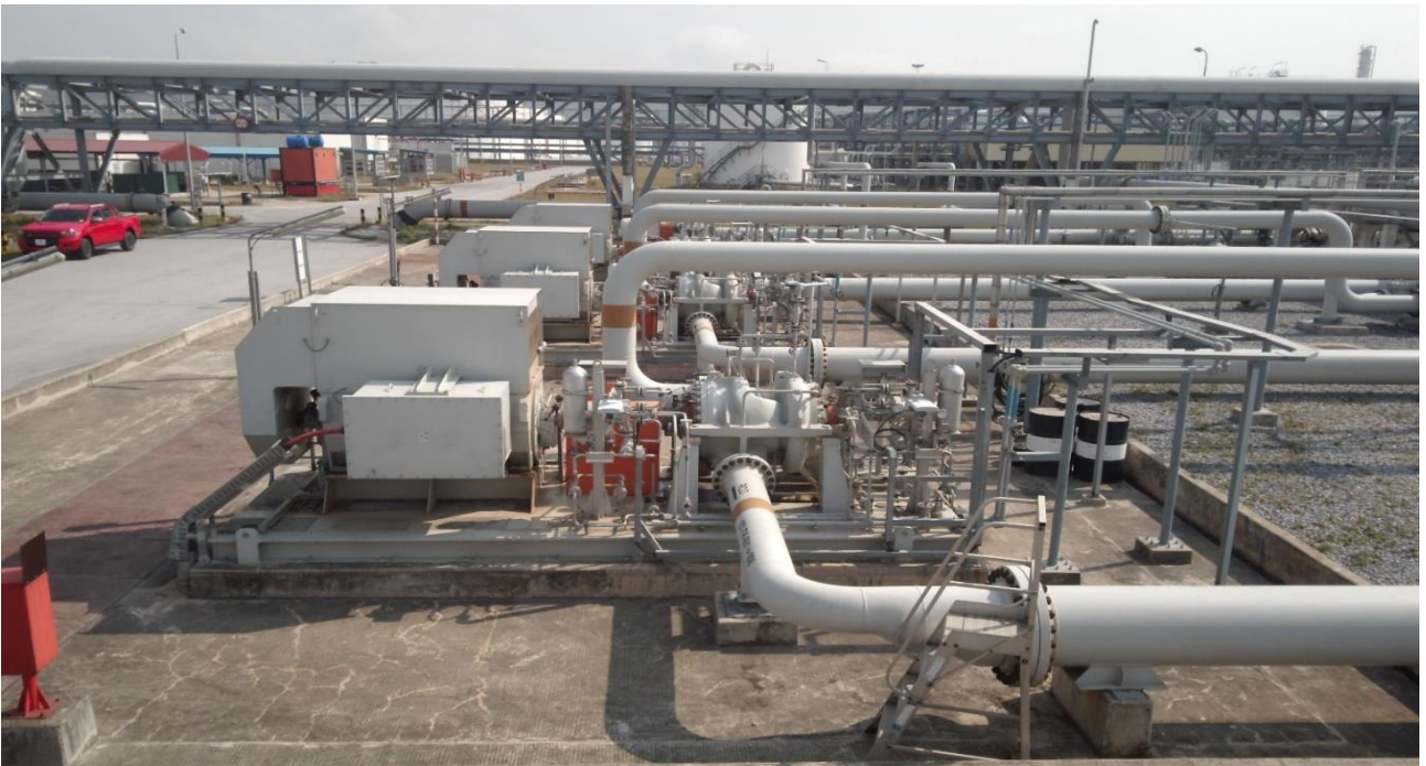
Рисунок 2.6 – Перекачивающие насосы на нефтебазе «Нги Сон»
