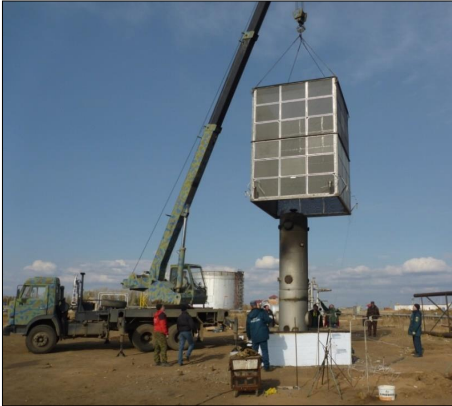
Рисунок 4.15 – Кадр монтажа противопожарного устройства
