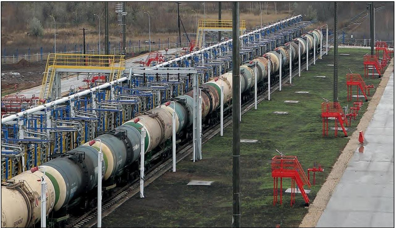
Рисунок 1.1 – Общий вид железнодорожной сливоналивной эстакады
