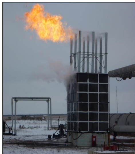
Рисунок 12 – Применение противопожарного устройства для рассеивания паров СПГ при аварийной утечке из оборудования
