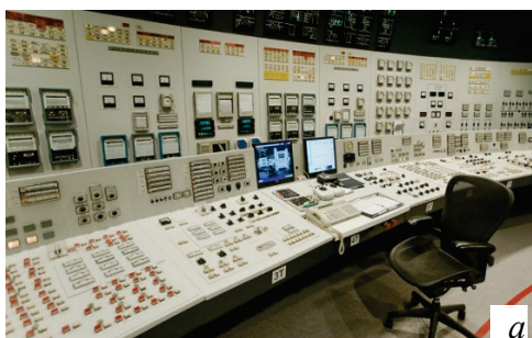
Рисунок 2.4 – Блочный щит управления АЭС
