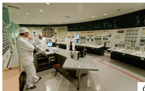
Рисунок 2.4 – Блочный щит управления АЭС
