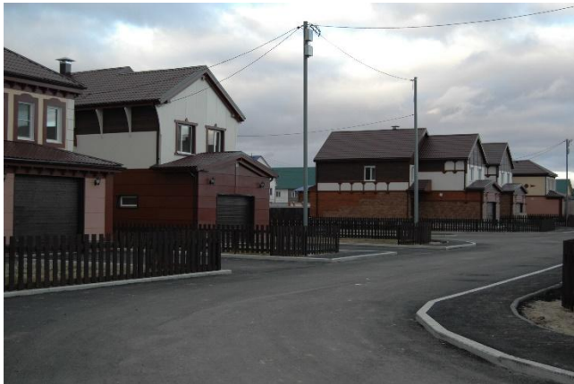
в) объекты завершеного строительства в микрорайоне ОМК, г. Ханты-Мансийск [162]
