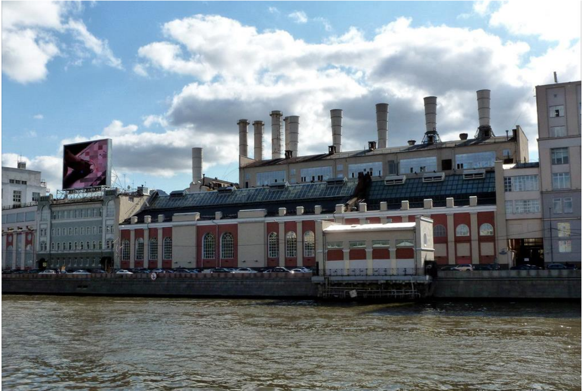
Рисунок 1.2 – Характерный вид производственных зданий ГЭС (Москва, ГЭС-1) [34]
