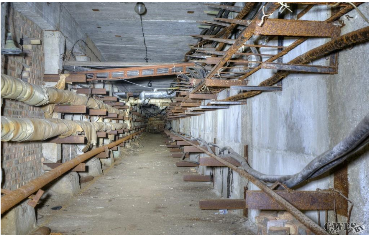
Рисунок 1.9 – Трубно-кабельный коллектор [34]
