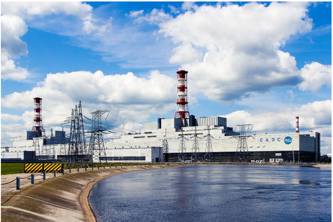
Рисунок 1.3 – Характерный вид производственных зданий АЭС (Смоленская область) [34]
