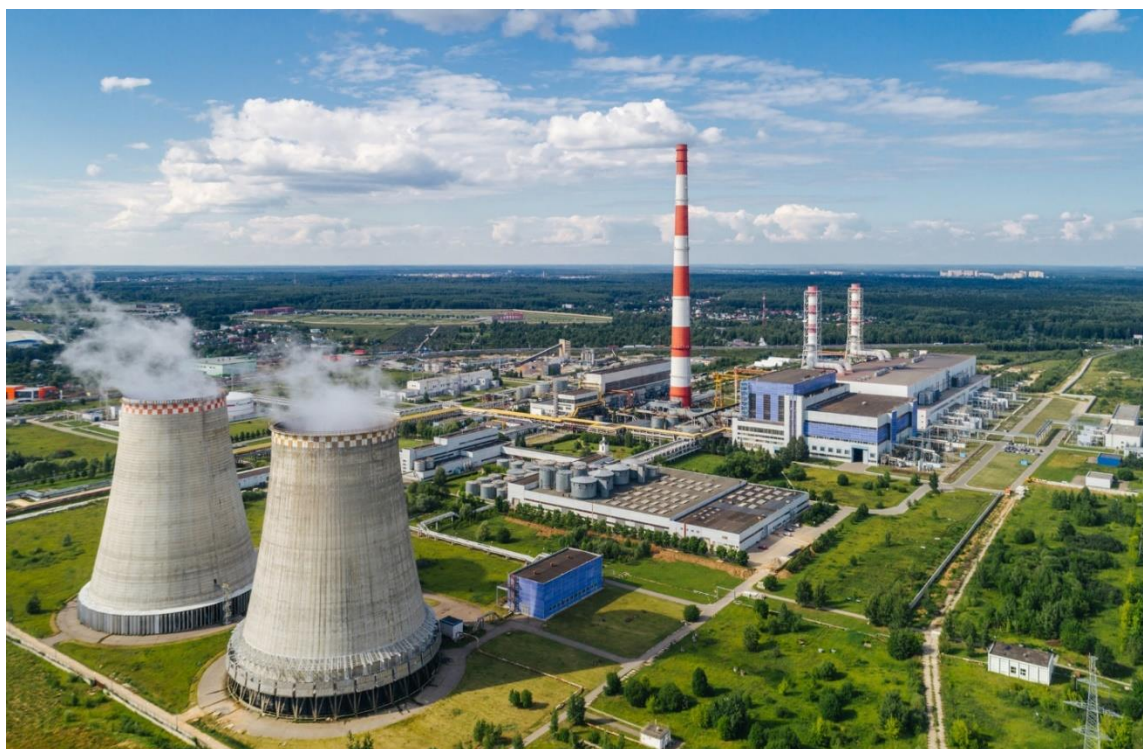
Рисунок 1.1 – Характерный вид производственных зданий ТЭЦ (Московская область) [34]
