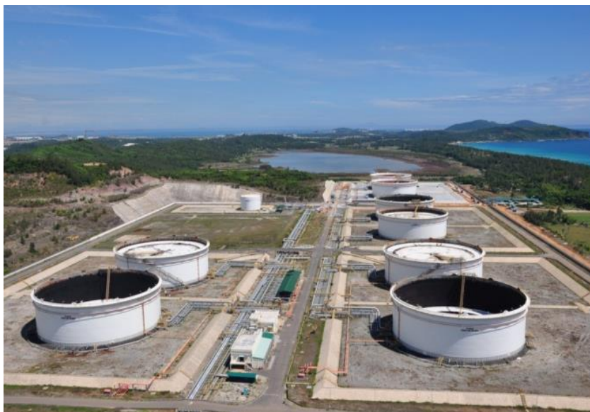
Рисунок 7 – РВСПК-65000 м 3 для хранения сырой нефти на НПЗ «Зунг Куат» в СРВ
