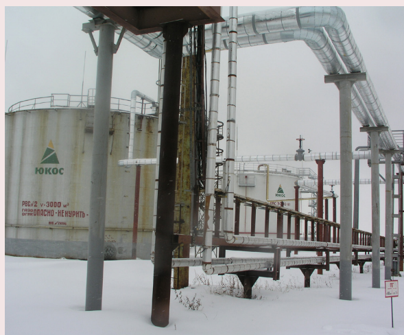
Обвязка резервуаров трубопроводом газораздаточной системы для подачи азота в резервуары
